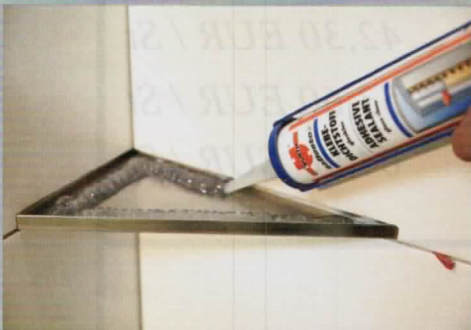
Fliese oder Glas mit Neutralsilikon bzw. Spezialkleber anbringen
