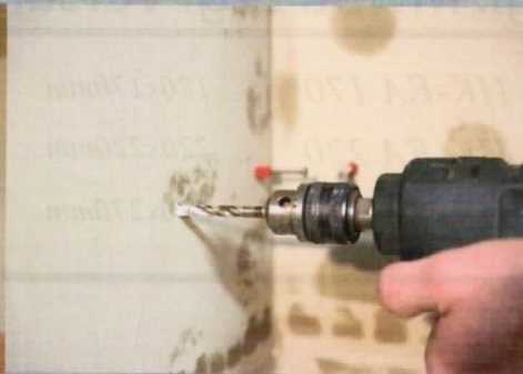
Bohren und Setzen der Dübel
