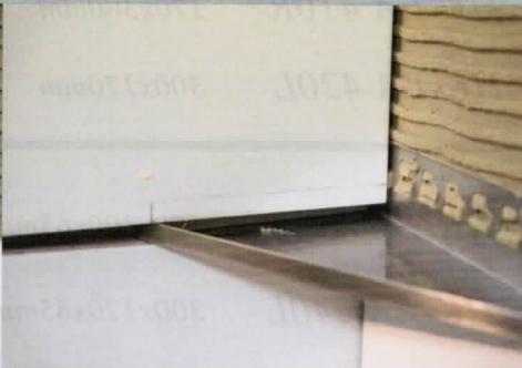
Fliese anzeichnen und ausklinken
